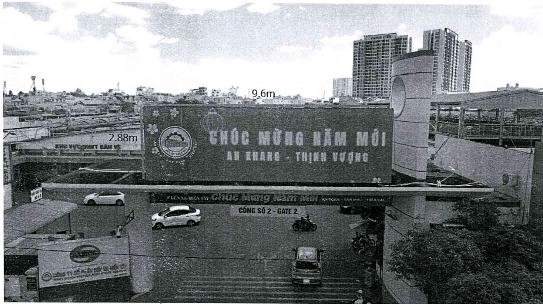
Hình số 12: Khu vực màn hình Led Module Outdoor P5 - cổng số 2
