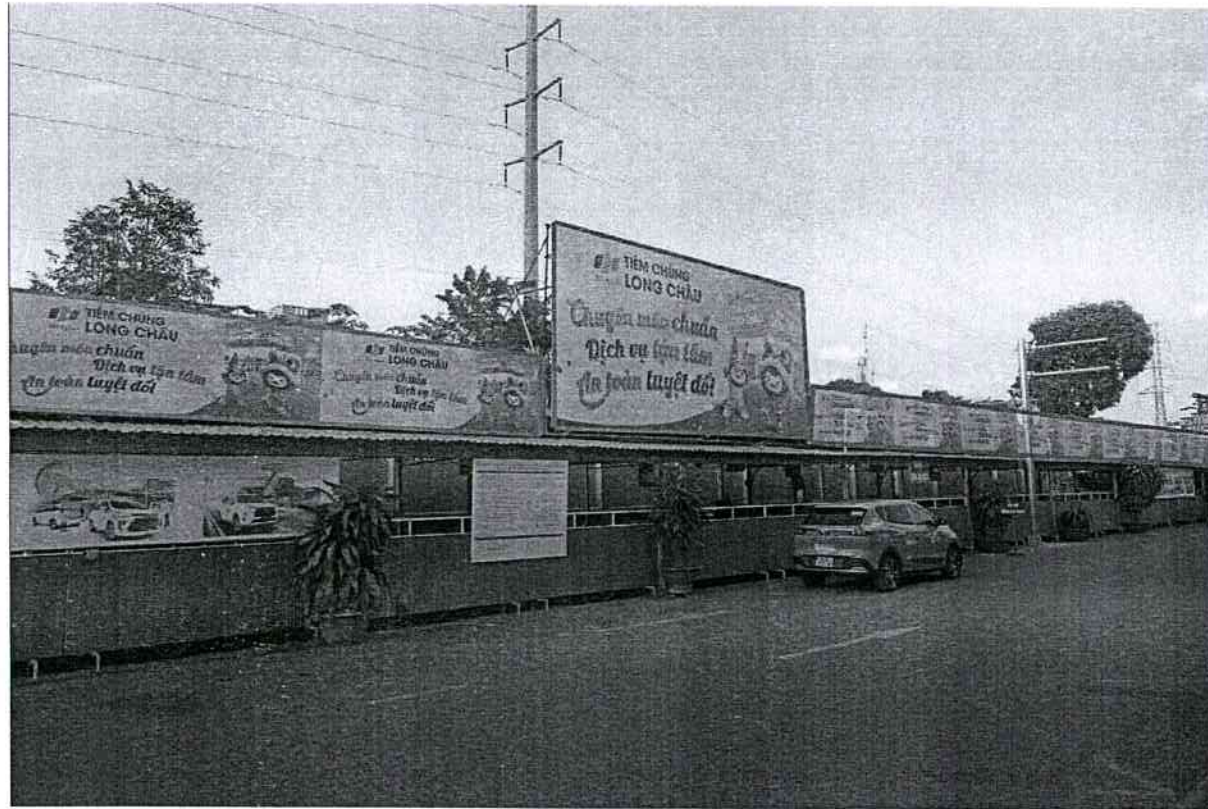
Hình số 6: Khu vực bảng quảng cáo phía trên Bãi giữ xe số 2 (Hình ảnh đã được khai thác trước đó, hiện tại đang trống)
