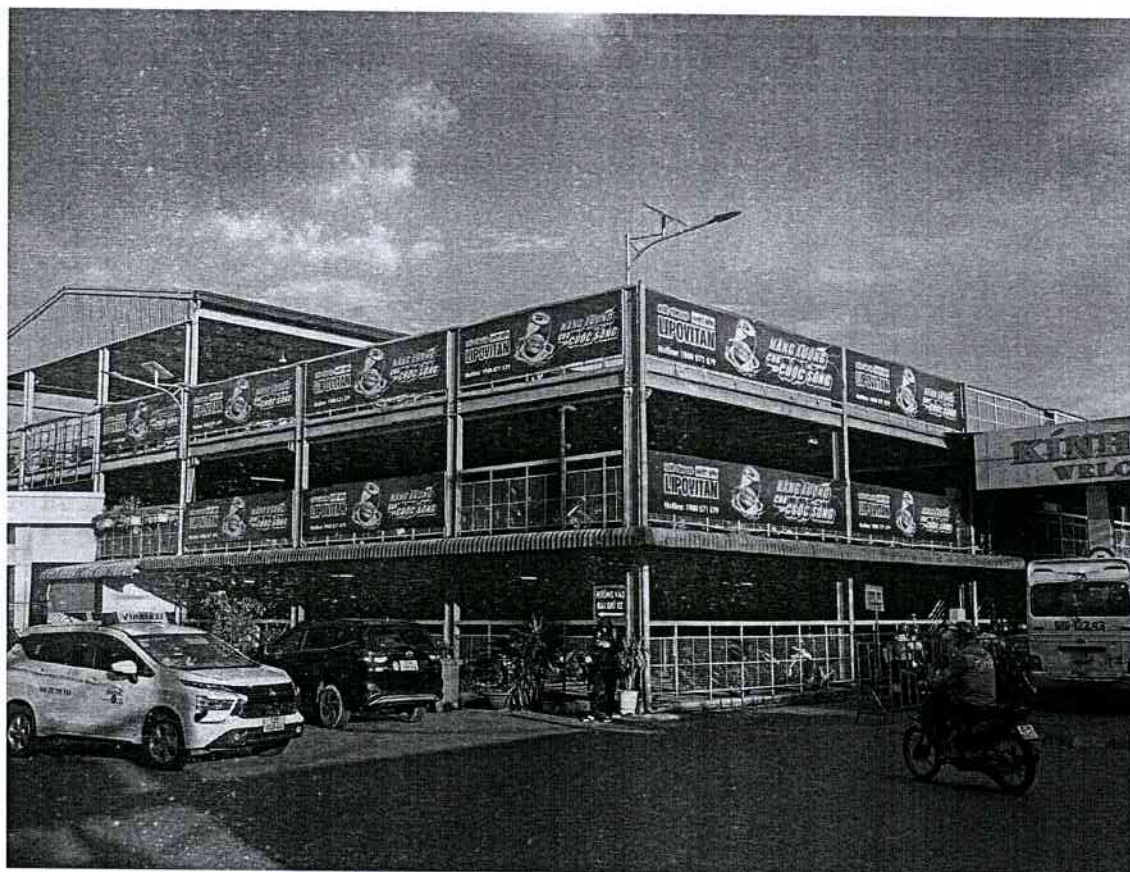
Hình số 7: Khu vực bảng quảng cáo Bãi giữ xe số 1 (Hình ảnh đã được khai thác trước đó, hiện tại đang trống)
